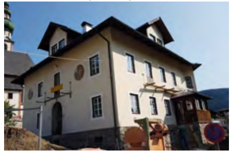
Renovierung Pfarrhof Oberau
